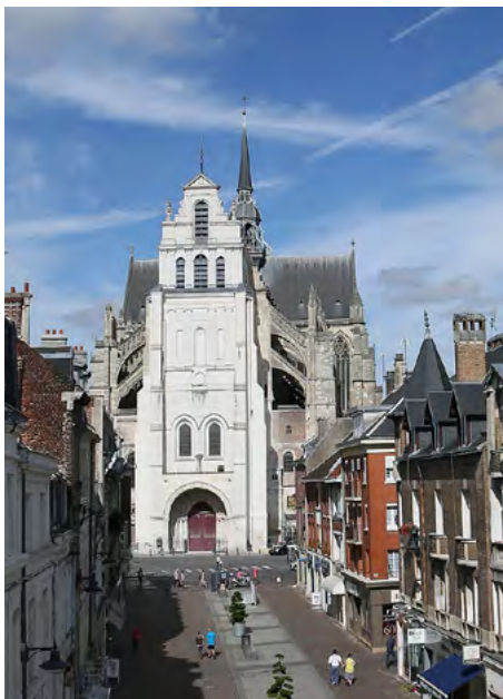
La tour occidentale. Un porche y a été percé dans la deuxième moitié du XII e siècle. Cette tour fait désormais office de façade à la basilique. Photographie, Ville de Saint-Quentin, Luc Couvée
